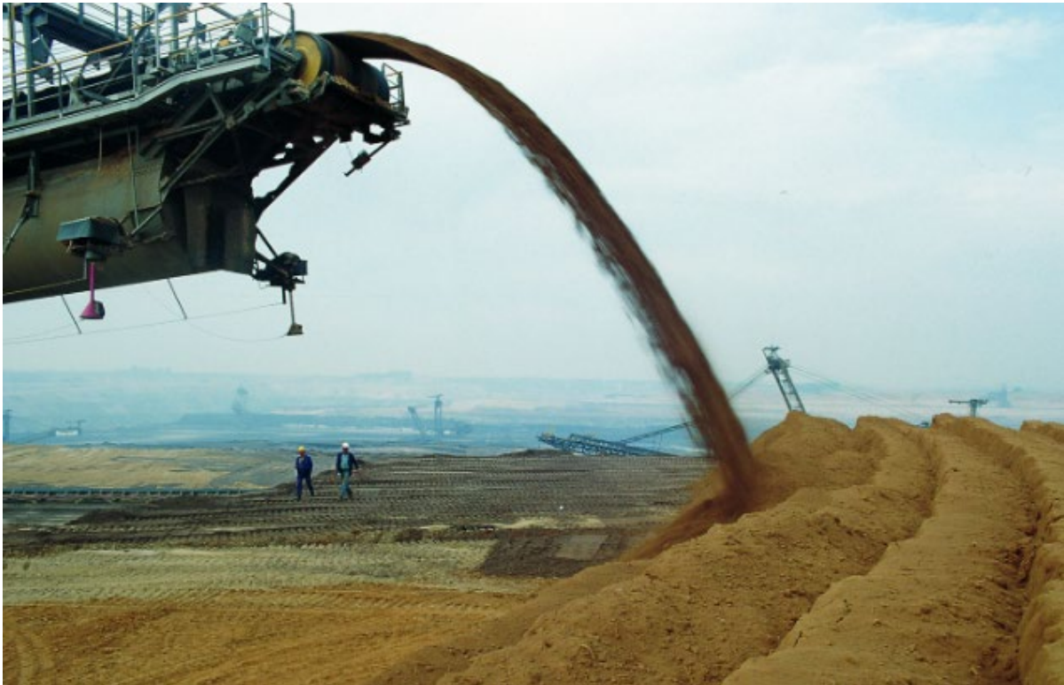
Abbildung 1: Verteilung des Rekultivierungssubstrates mit dem Absetzer (Forschungsstelle Rekultivierung, 2024b)
